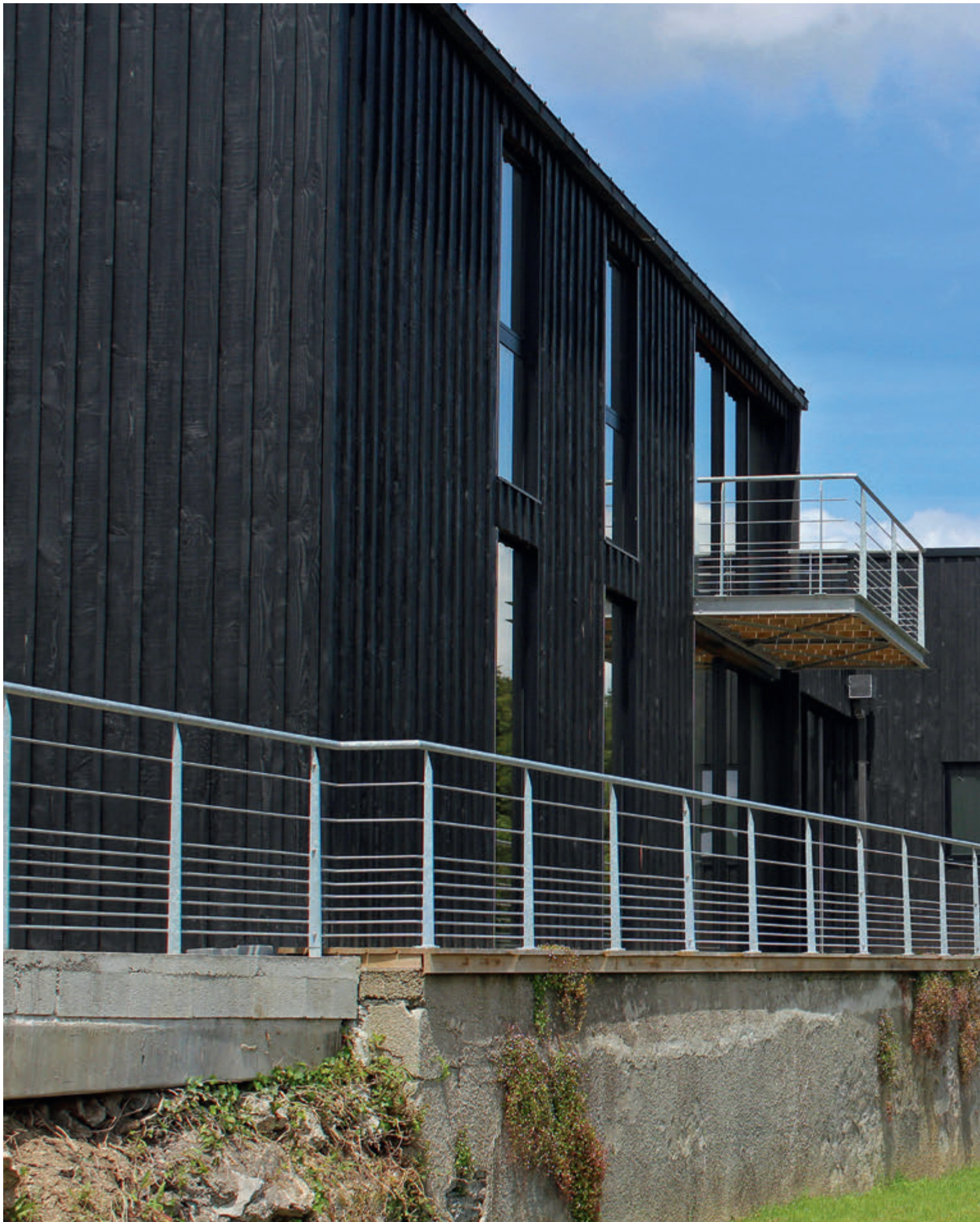
Domotic Fermetures / À Saint-Martin-des-Champs (29) / Guyader Architecte
