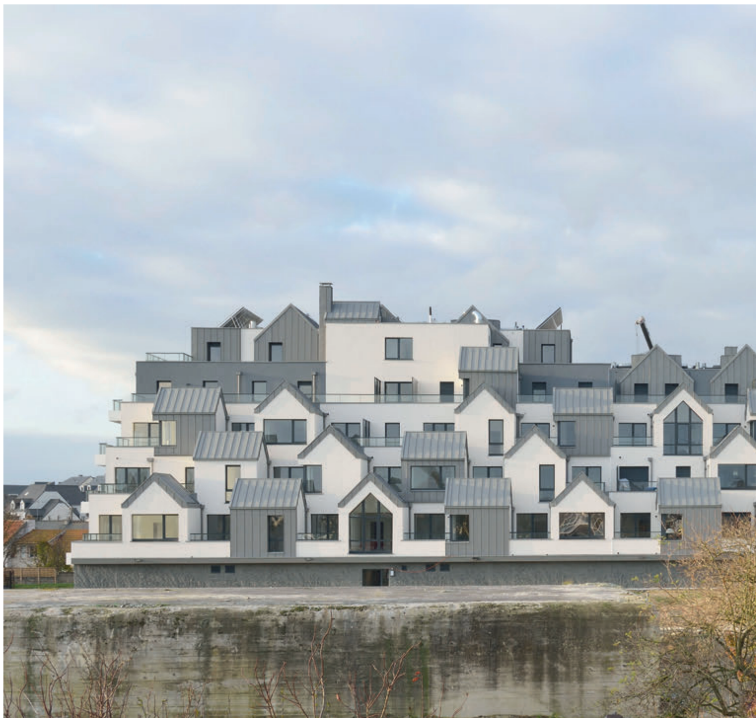
Les Terrasses du Rocher / À Saint-Malo (35) / Atelier Loyer Architectes
