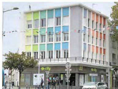
Le bâtiment au-dessus du Carrefour City, à la croisée de l'avenue Anatole-France et de la rue de la Belle-Fontaine, a été colorié en juillet.
